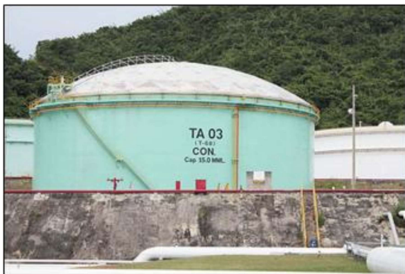
ถังแบบ Internal Floating Roof
