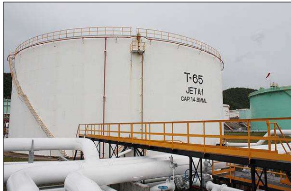
ถังแบบ Cone Roof
